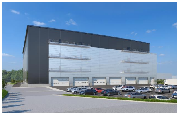
(仮称)佐野市物流倉庫計画 所在地:栃木県佐野市伊勢山町宇伊勢山北977番1他(地番) 延べ床面積:26,937.68㎡ 構造:鉄骨造 地上4階建
