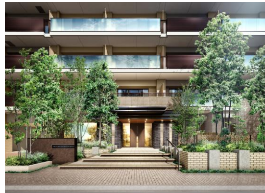
エントランスアプローチ
