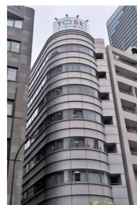
全館LED工事を実施した 淡路町トーセイビル
