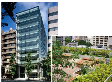
虎ノ門トーセイビル 屋上
