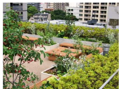
【虎ノ門トーセイビル 屋上緑化】
