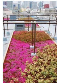
既存ビル屋上緑化
