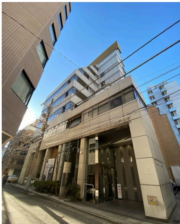
新橋フロンティアビル
