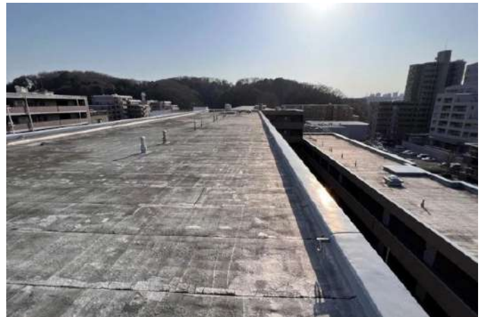
太陽光発電設備導入予定の屋上
