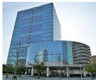
横浜市オフィスビル
