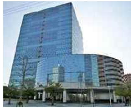
横浜市オフィスビル
