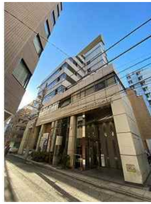
新橋フロンティアビル
