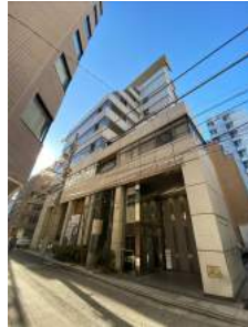
新橋フロンティアビル
