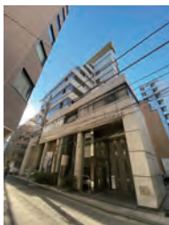
新橋フロンティアビル
