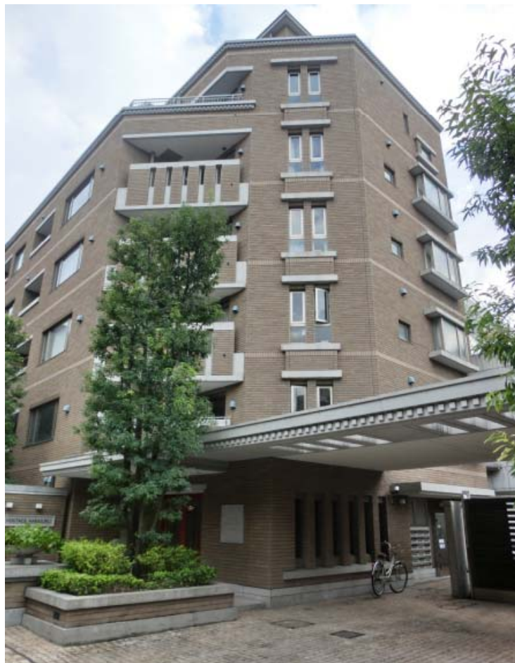
【収益マンション】原宿マンション
