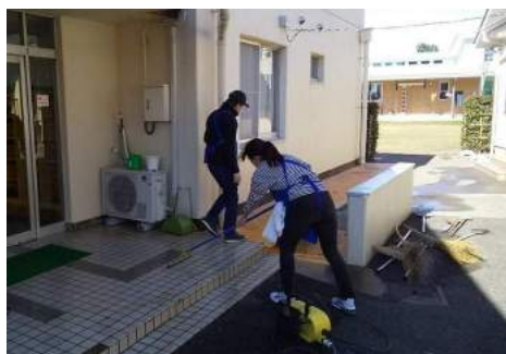
洗浄作業の様子
