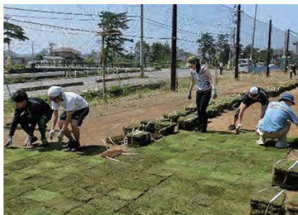
グラウンド整備
